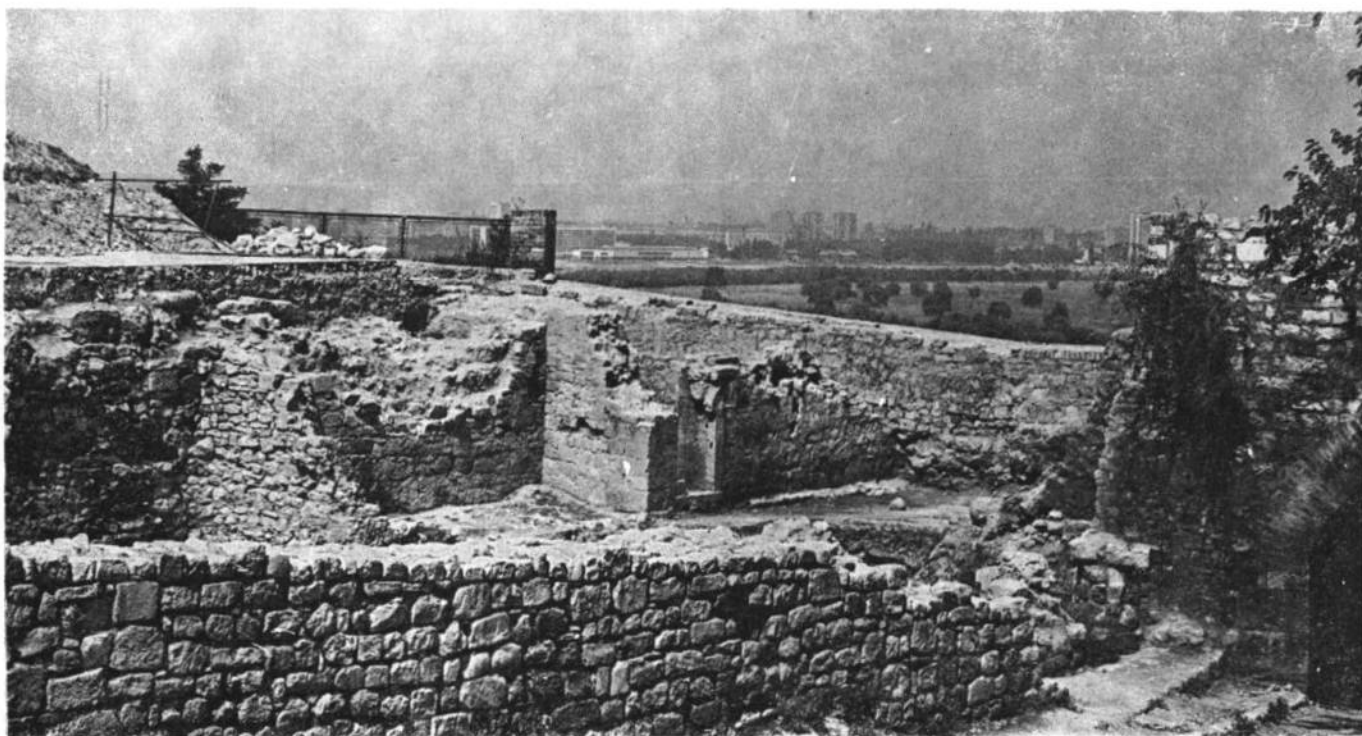
Сл. 1 — Изглед улазног дела Унутрашњег града после откривања
